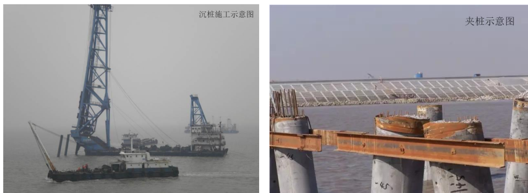
图 2.3-2 沉桩施工和夹桩示意图
